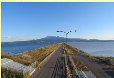
写真12. 諫早湾の潮受け堤防(右が陸側で淡水、左が有明海につながる)
